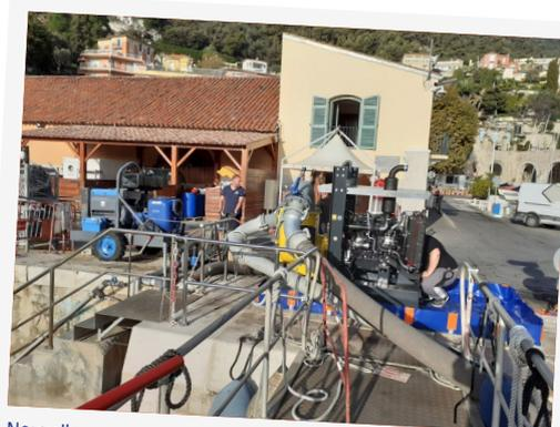
Nouvelle pompe automotrice d'assèchement du bassin de radoub en cours d'installation (sans capotage d'insonorisation)
