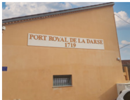
Enseigne murale pignon capitainerie déjà existante
