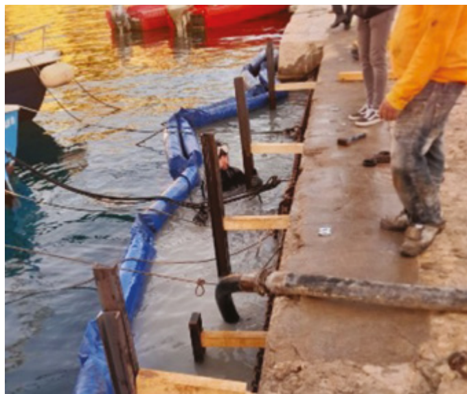
Injection béton formulé pour une prise en milieu marin
