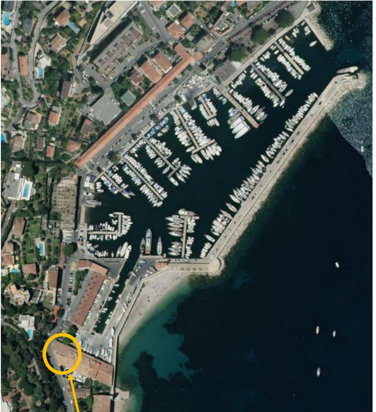
Bâtiment B, chemin du Lazaret
